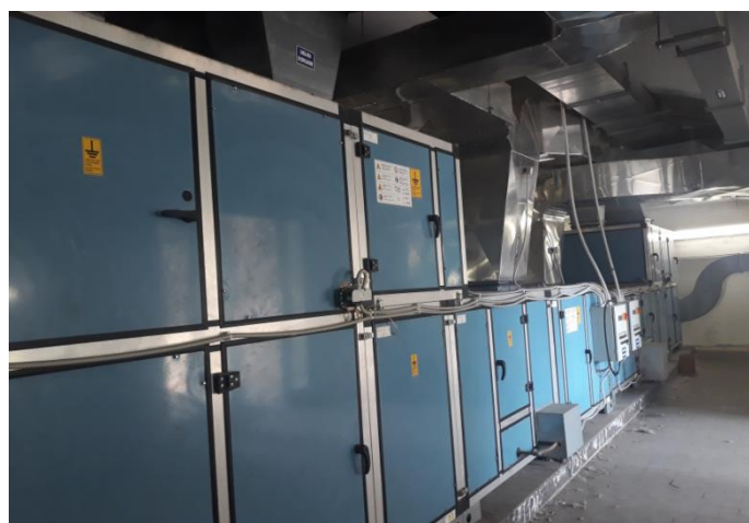
Figura 2.10: Unità di trattamento dell'aria installata nella sotto-centrale dedicata.
