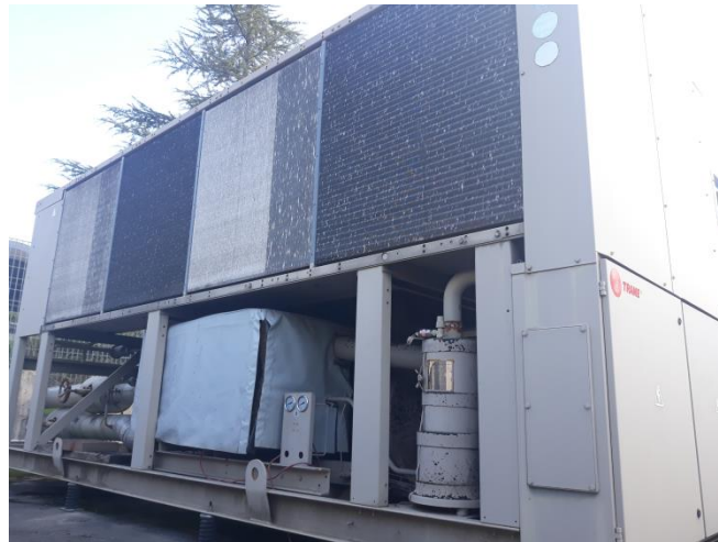
Figura 2.9: Macchine frigorifere allocate in uno spazio esterno della centrale.
