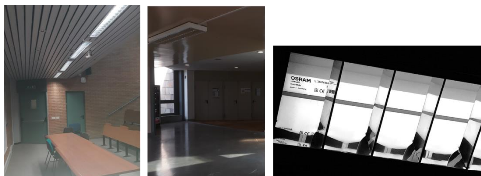
Figura 2.13. Sistema di illuminazione zona aula e atrio. Tipologia di lampade fluorescenti installate.
