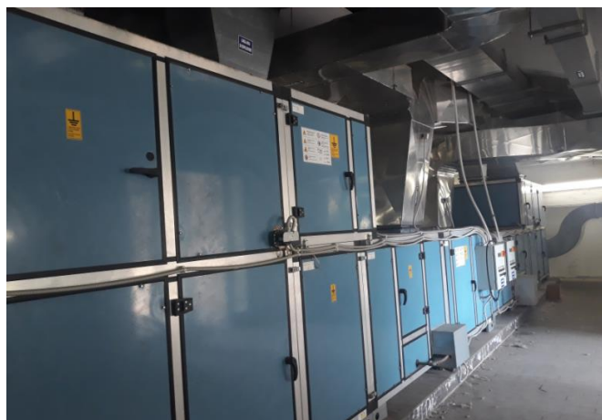
Figura 16 - Unità di trattamento dell'aria installata nella sotto-centrale dedicata
