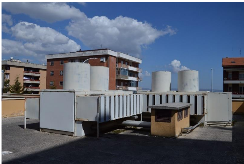
Figura 3 - Macchine frigorifere allocate sul tetto della centrale
