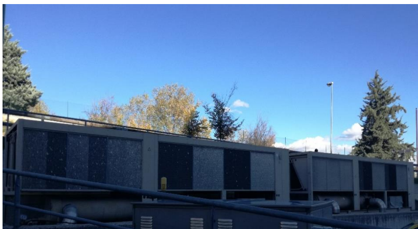
Figura 2. 11: Macchine frigorifere allocate in una posizione adiacente all'edificio.
