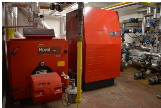
Figura 2 - Caldaie Hoval asservite all'edificio
