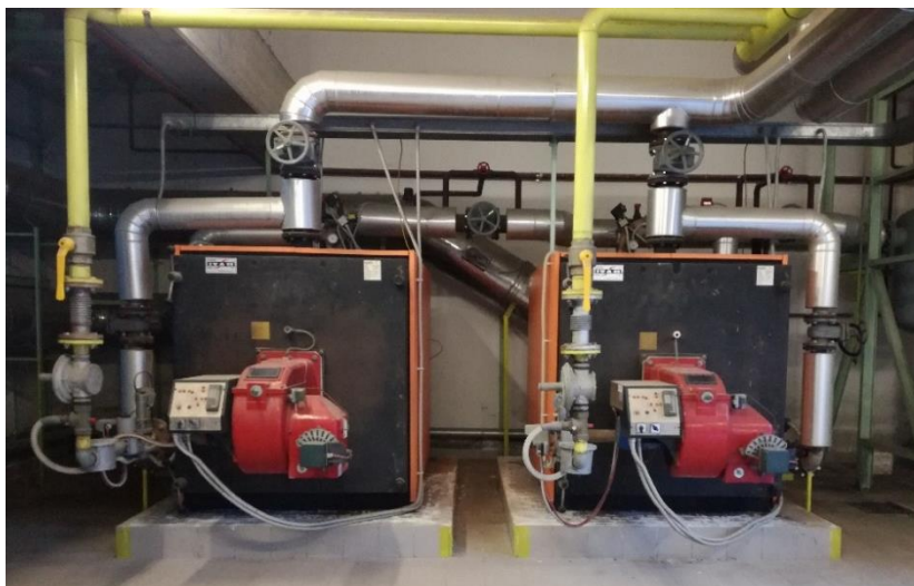
Figura 2. 10: Caldaie asservite all'edificio.
