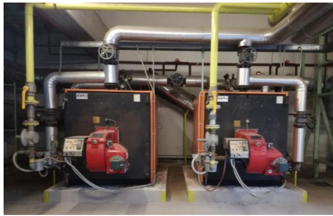
Figura 9 – Caldaie IVAR asservite all'edificio
