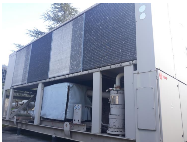
Figura 15 - Macchine frigorifere allocate in uno spazio esterno della centrale
