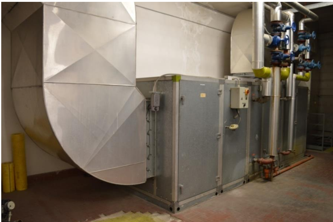
Figura 4 - Unità di trattamento dell'aria installata nella centrale dedicata
