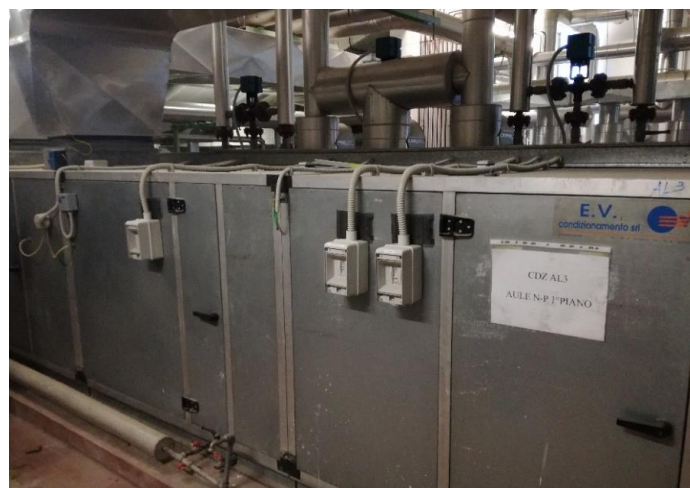
Figura 11 - Unità di trattamento dell'aria installata nel sottotetto della struttura
