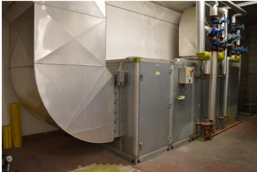
Figura 2. 15: Unità di trattamento dell'aria installata nella centrale dedicata.
