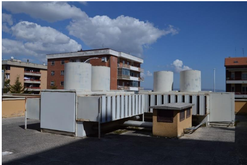
Figura 2. 14: Macchine frigorifere allocate sul tetto della centrale.
