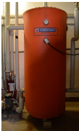
Figura 5 – Serbatoio di accumulo per ACS
