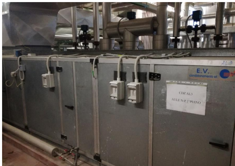
Figura 2. 12: Unità di trattamento dell'aria installata nel sottotetto della struttura.
